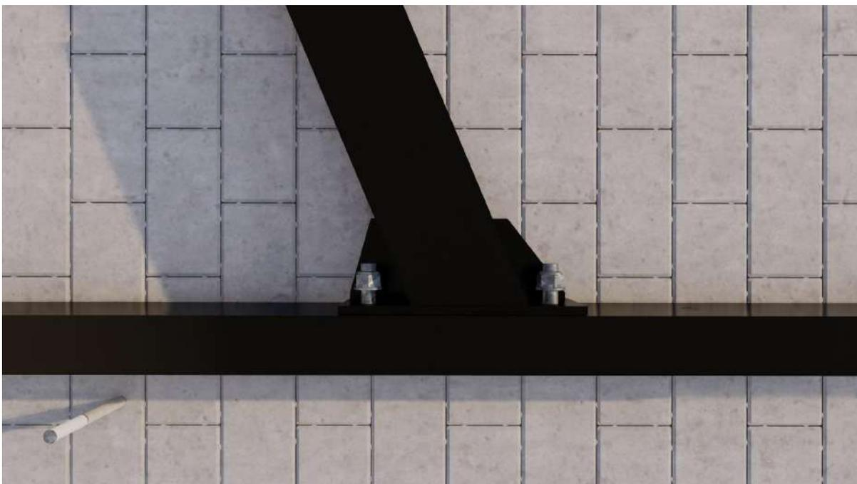
○ **Schritt 7** -Eckpfosten und Dachbalken verbinden
